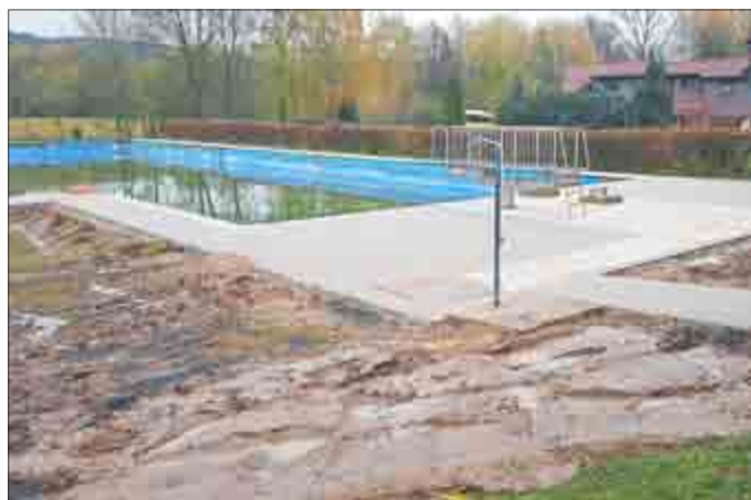
Beckenrandsanierung Schwimmbad
